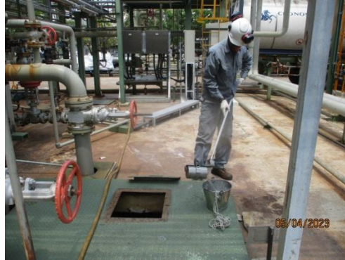
บ่อตรวจสอบคุณภาพน้ำเสียของโรงงาน ก่อนส่งเข้าระบบบำบัดน้ำเสียของโรงงานผลิตสารคาโปรแลกทัม (Influent)
